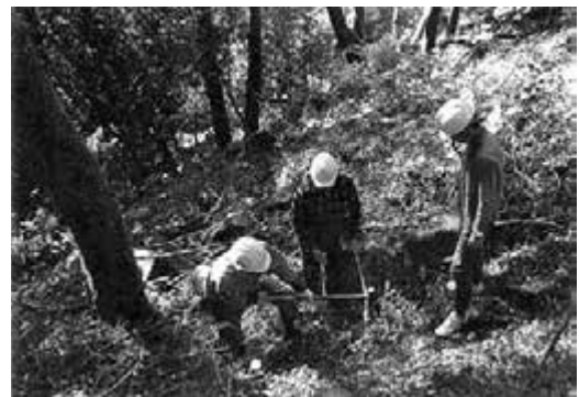
作業道の整備
